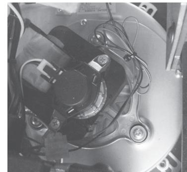
**Sensor de temperatura do fumo:** este termopar controla a temperatura do fumo e dá a ordem de acender ou apagar a estufa quando a temperatura do fumo desce por baixo do valor de referência.
